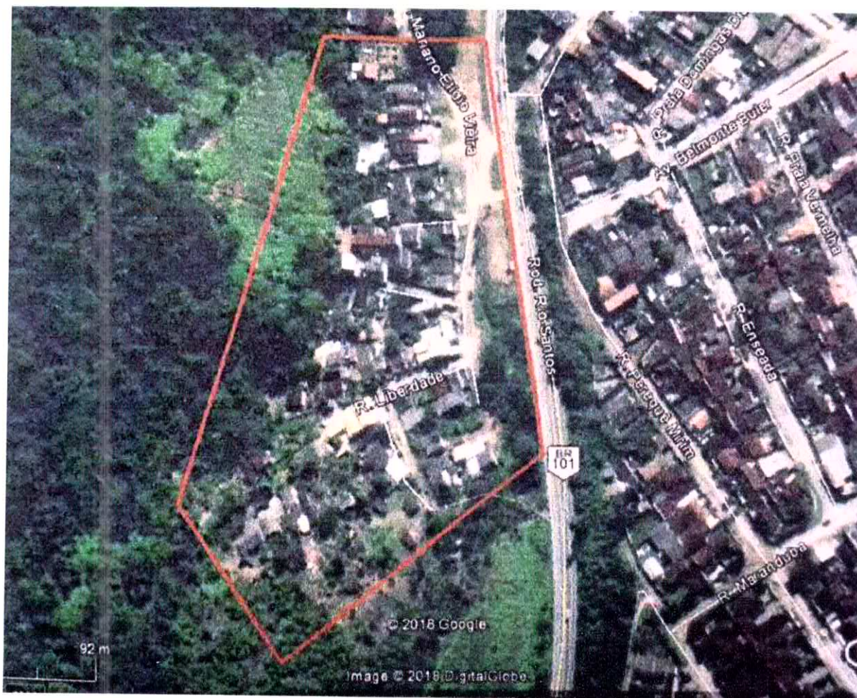
Figura 1: destaque em vermelho, poligonal do núcleo "Loteamento Jardim Ubatuba II", Distrito Sede - Bairro: Sumidouro.
